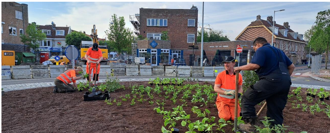
Foto: inplanten rotonde Mosplein door Stadswerken.
